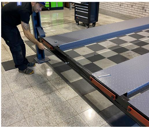
31. Montera ögleskruvarna för de långa länkagen och trä igenom dem.
