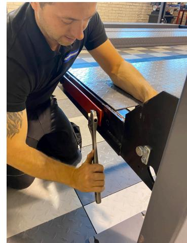
16. Bulta fast rampen och plattjärnen för uppkörningsramperna.
