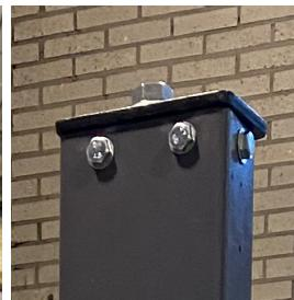
9. Bulta fast topplocken med 4st bult och mutter.
